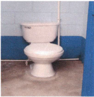
Foto 3: SUSTITUCIÓN DE BAÑOS
