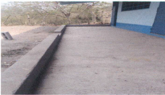
Foto 5: COLOCACIÓN DE BORDILLO
