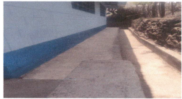
Foto 4: ELABORACIÓN DE CUNETETA DE AGUA FLUVIAL
