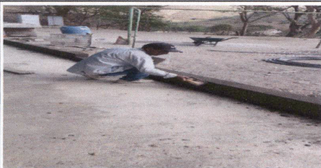
Foto 5: COLOCACIÓN DE BORDILLO
