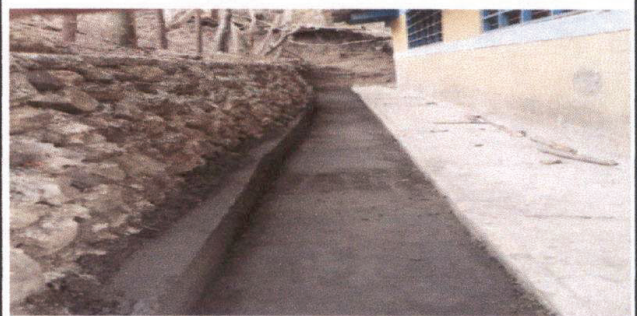
Foto 4: ELABORACIÓN DE CUNETA DE AGUA FLUVIAL
