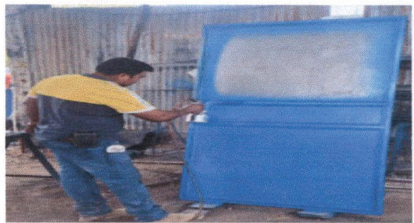
Foto 6: REPARACIÓN, PINTADO Y CAMBIO DE CHAPA DE PUERTA
