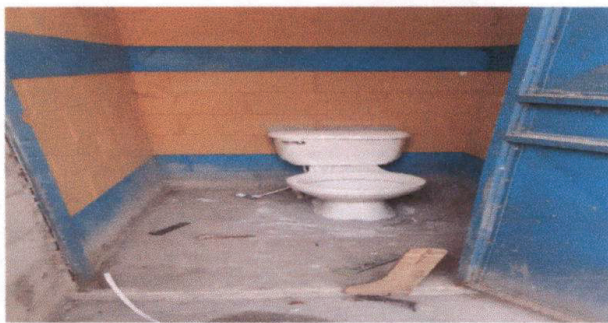
Foto 3: SUSTITUCIÓN DE BAÑOS
