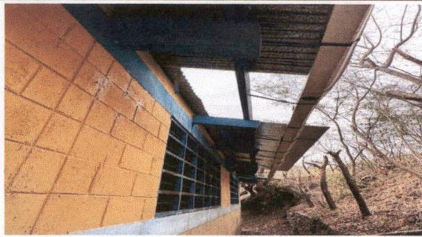
Foto 1: REPOSICIÓN DE LAMINAS EN TECHO
