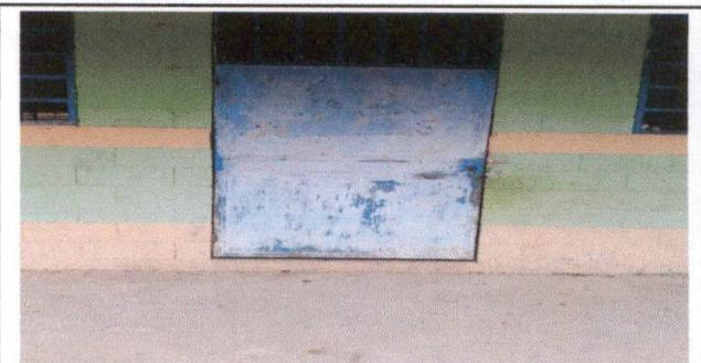
Foto 6: REPARACIÓN, PINTADO Y CAMBIO DE CHAPA DE PUERTA
