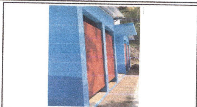
Foto 2: Sustitución de Puertas.
