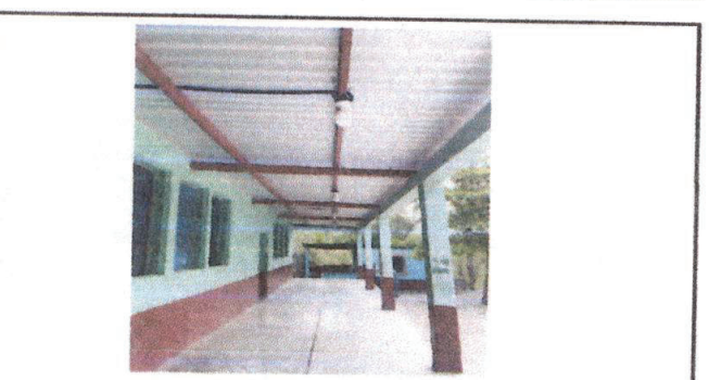
Foto 5: Instalación de Energía Eléctrica.
