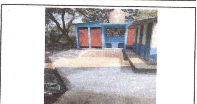
Foto 4: Fraguado de Patio de Sanitarios.
