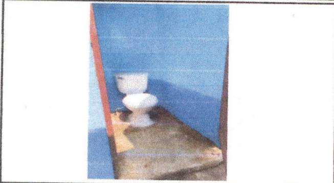
Foto 1: Sustitución de Sanitarios.
