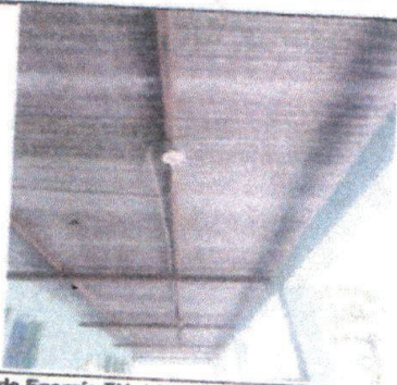
Foto 5: Instalación de Energía Eléctrica.
