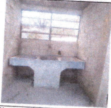
Foto 3: Cambio de Ventanales y Pila de Sanitarios.
