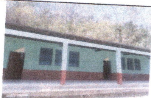
Foto 6: Cambio de Techo.
