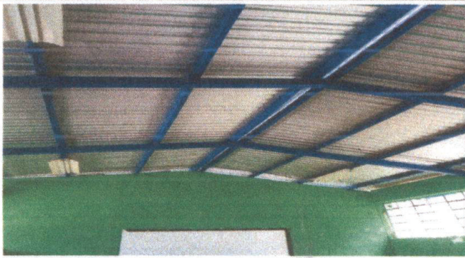
Foto 1: Reparación de costaneras
