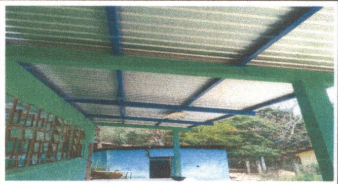
Foto: Techo del edificio escolar
