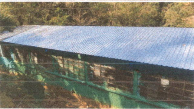
Foto 3: finalización del techo del edificio escolar
