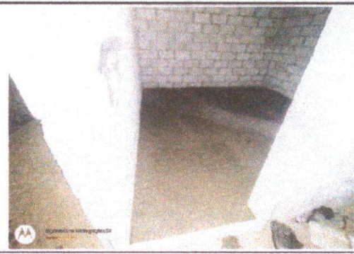
Foto 6: Fundición de piso
