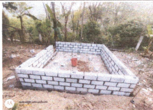
Foto 3: Inicio de construcción de cocina
