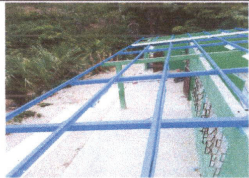
Foto 2: Pintado de estructura
