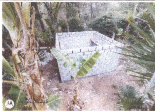
Foto 4: Proceso de construcción de cocina
