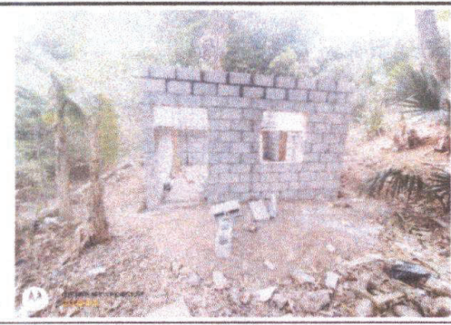
Foto 5: Seguimiento de la construcción de la cocha
