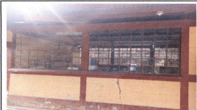
FOTO 3: Mantenimiento de ventanas
