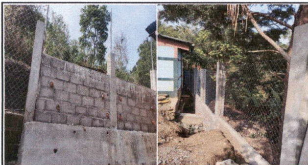
FOTO 5: Construcción de muro perimetral
