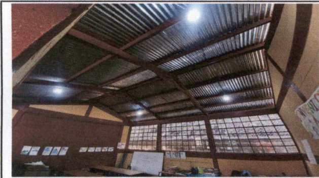
FOTO 1: Sustitución de lámparas
