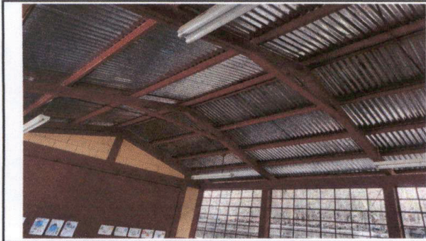
FOTO 1: Sustitución de lámparas
