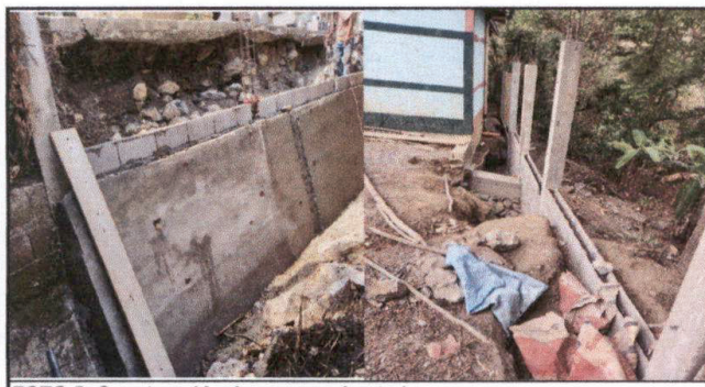
FOTO 5: Construcción de muro perimetral
