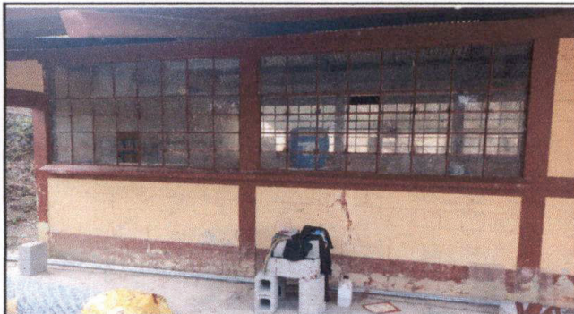
FOTO 3: Mantenimiento de ventanas
