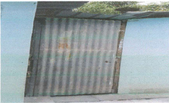
Foto 5: Sustitución e instalación de puerta de metal
