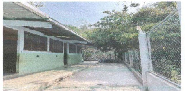
Foto 6: Pintura en muros exteriores e interiores
