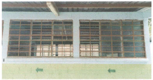
Foto 4: Sustitución de ventanales
