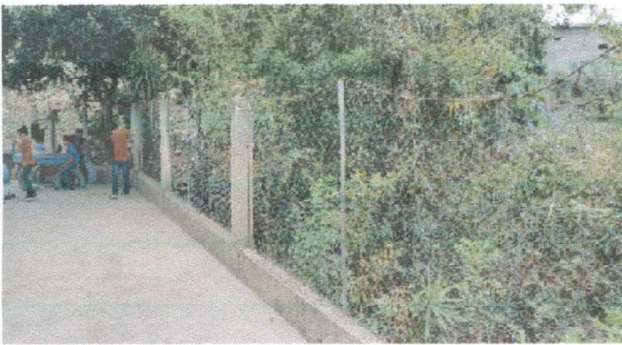
Foto 3: Reparación de muro perimetral
