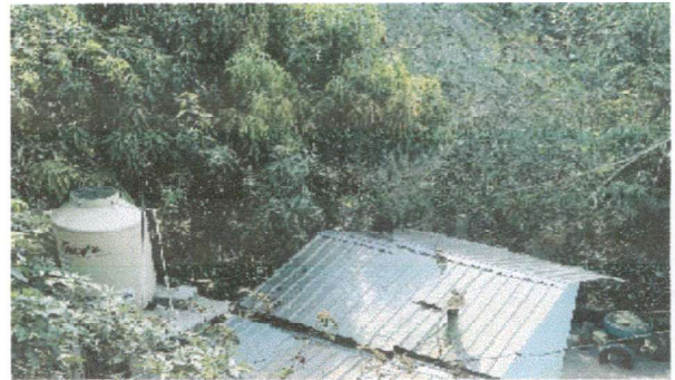
Foto 2: Sustitución de lámina troquelada aluzinc
