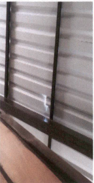
Foto 5: Reparación de techo
