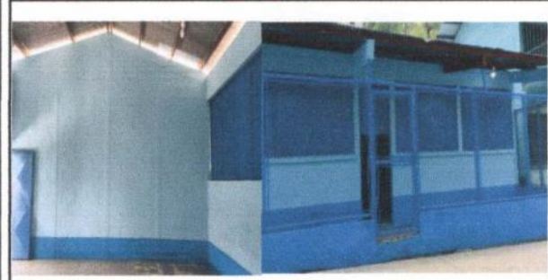
Foto 3: Pintura en muro exterior e interior culminado
