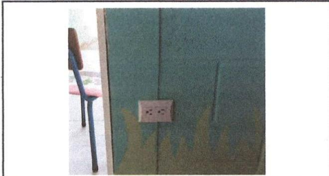
Foto 15: Sustitución de tomacorrientes dobles
