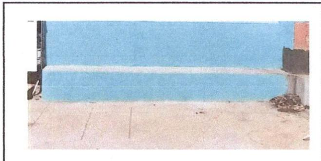
Foto 18: Reparación de muro de contención
