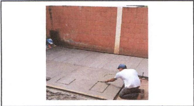
Foto 13: Sustitución de planchas de cemento de patio
