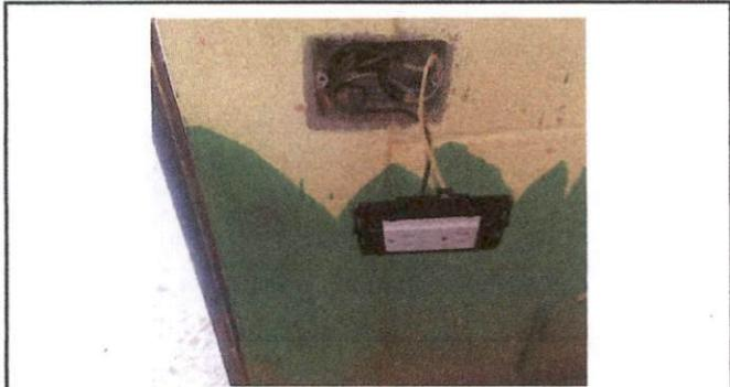
Foto 15: Sustitución de tomacorrientes dobles
