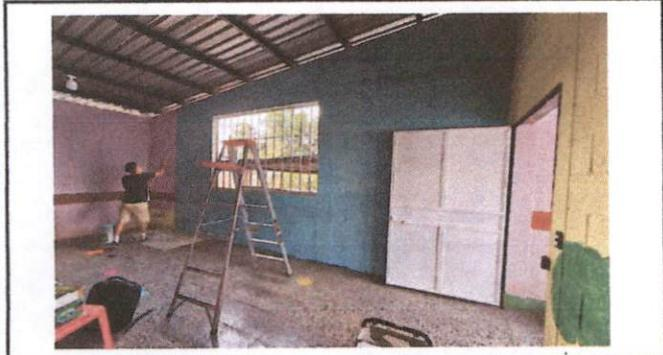
Foto 7: Pintura en interior y exterior en toda la escuela, debido al deterioro de la pintura actual
