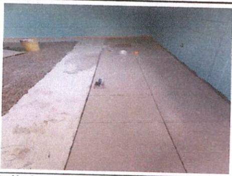
Foto 5: Sustitución de piso por piso cerámico
