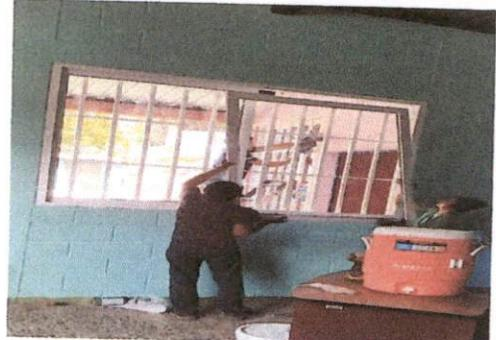
Foto 4: Colocación de ventanas de PVC
