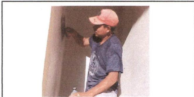
Foto 17: Reparación de repello y cernido de paredes de baños
