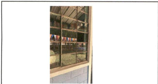
Foto 3: Sustitución de ventana de metal de vidrio por ventana de pvc
