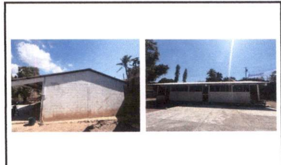
Foto 6: cambio de pintura
