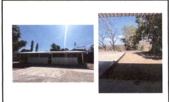
Foto 4: Ampliación de cancha y construcción de escenario.
