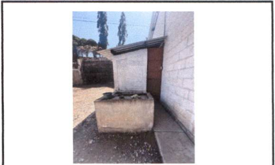
Foto 2: Instalación de lavamanos con instalación de tubería y drenaje.
