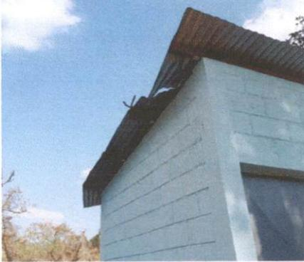
Foto 3: Sustitución de lámina
