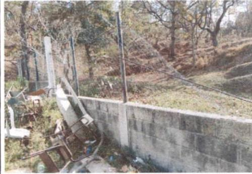
Foto 2: muro perimetral en mal estado, sustitución de malla
