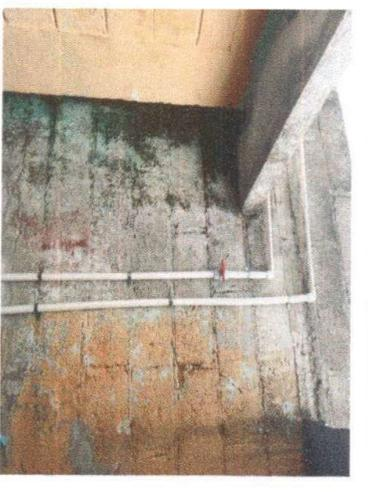
Foto 4: Cambio de tubería en el sistema de agua.
