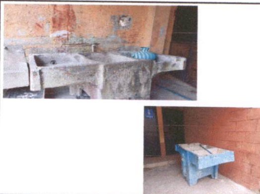
Foto 6: cambio de instalación de Pila
