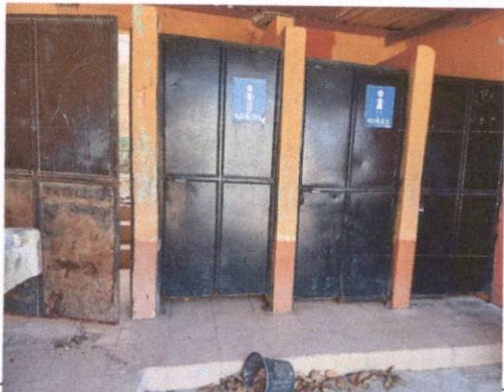
Foto 1: Puertas de los baños y cambio de sanitarios
