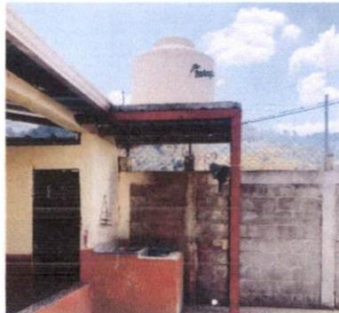
Foto 4: Cambio de tinaco y cambio de tubería en el sistema del agua
