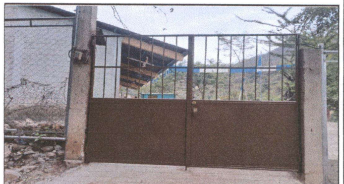
Foto 4: SUSTITUCIÓN DE PORTÓN DE METAL ENTRADA PRINCIPAL
