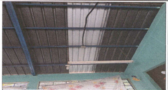
FOTO 2: CUBIERTA DE LÁMINA
