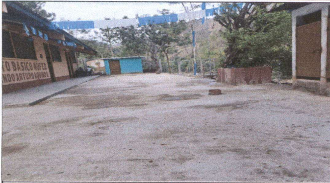
FOTO 1: PREPARACIÓN DE LOSA DE PATIO
