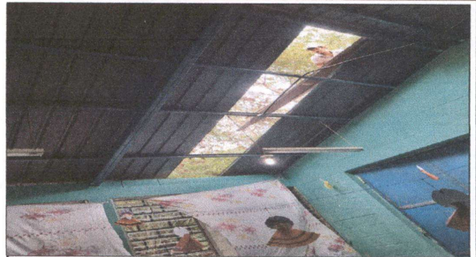
FOTO 2: CUBIERTA DE LÁMINA
