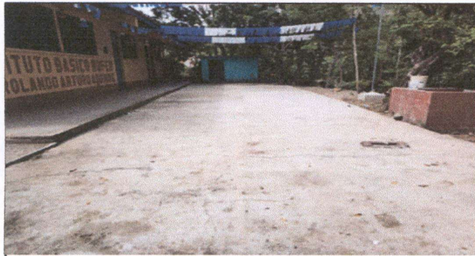
FOTO 1: PREPARACIÓN DE LOSA DE PATIO
