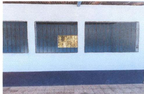
Foto 4: Muro exteriores repellado, cernido y pintado
