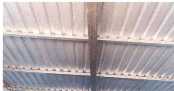
Foto 5: Sustitución de estructura de madera por soporte de metal y lámina troquelada
