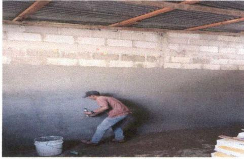
Foto1: Reparación de muros con repello
