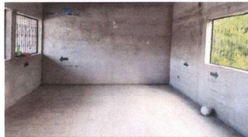
Foto 4: Los muros necesitan repello, cernido y pintura
