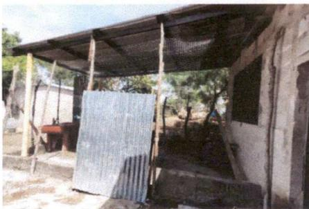
Foto 3: Los muros perimetrales necesitan ser reparados desde sus cimientos
