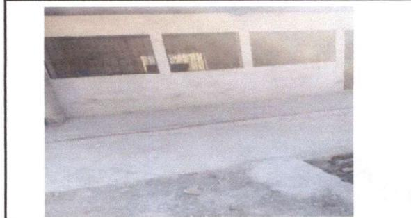
Foto 4: Los muros necesitan repello, cernido y pintura
