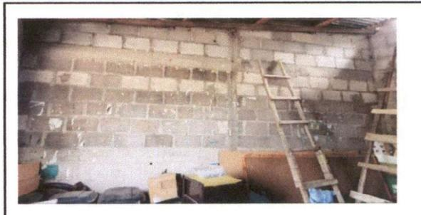
Foto 2: El muro perimetral necesita repello, cernido y pintura
