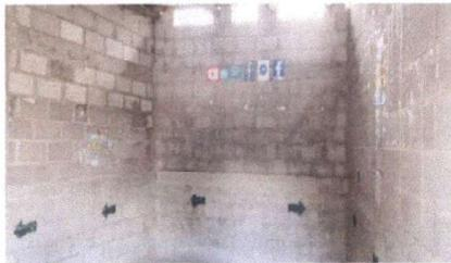
Foto 1: Las paredes del aula necesitan repello, cernido y pintura para tener un ambiente agradable
