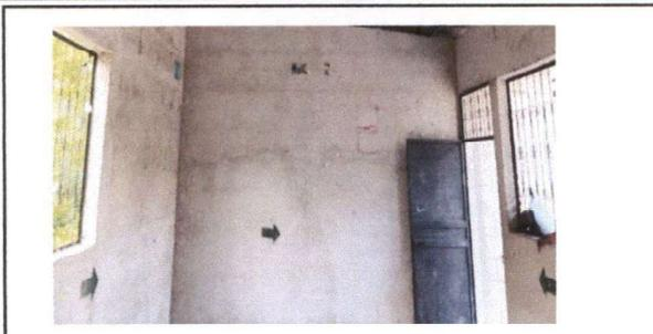
Foto1: Los muros necesitan repello, cernido y pintura para tener un ambiente agradable
