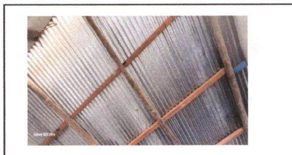
Foto 5: Sustitución de lámina por lámina troquelada
