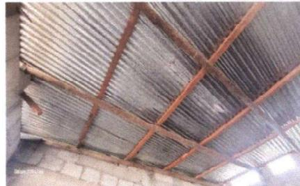
Foto 2: Sustitución de madera por estructura metálica
