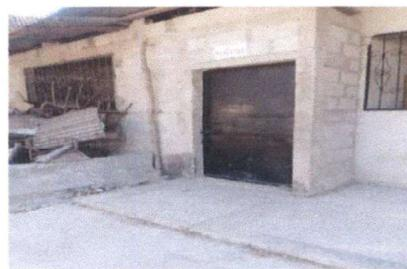
Foto 6: Los muros necesitan repello, cernido y pintura
