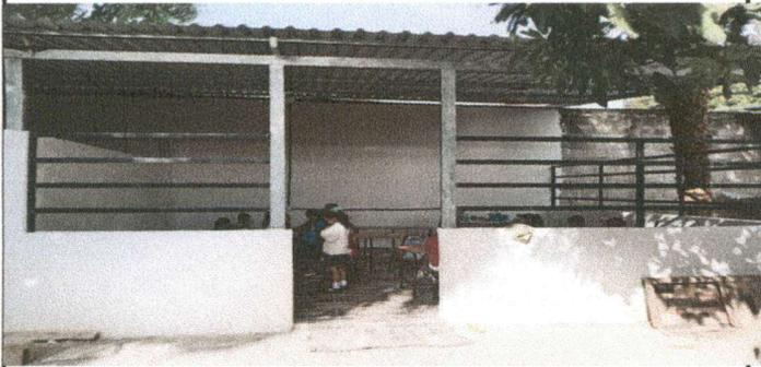
Foto 1: Sustitución de lámina troquelada aluzinc calibre 26
