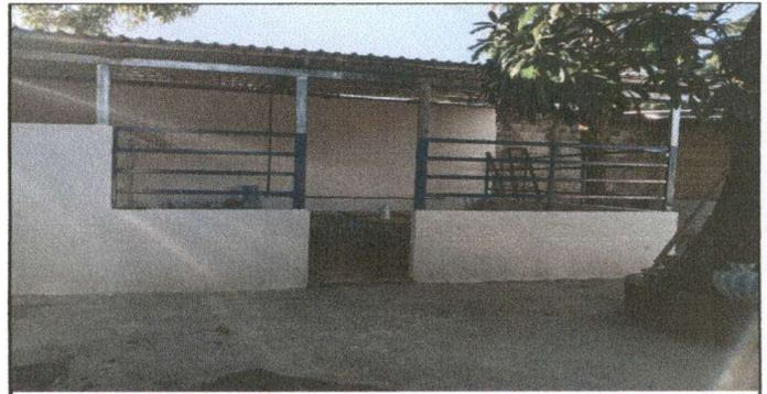
Foto 6: Sustitución piso torta de concreto
