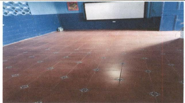
Foto 2: Sustitución de piso de granito por cerámico en una aula.
