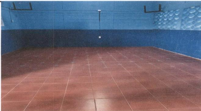
Foto 5: Reposición de piso de granito por piso cerámico en una aula.
