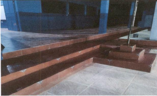
Foto1: Sustitución de piso granito por cerámico, así como colocación de piso en las gradas alrededor del patio.
