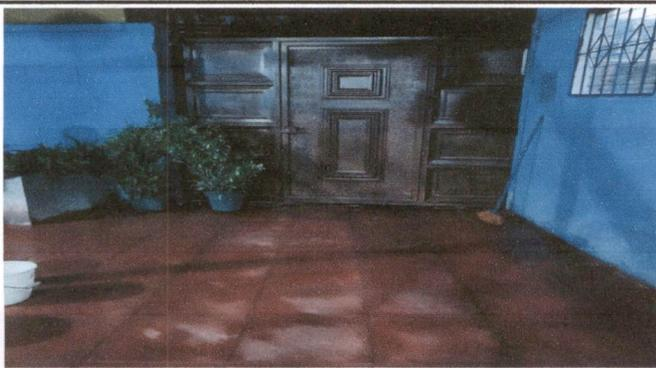
Foto 3: Reparación de portón principal convirtiendolo en corredizo, así como colocandolo una sombra para protegerlo del sol y la lluvia.
