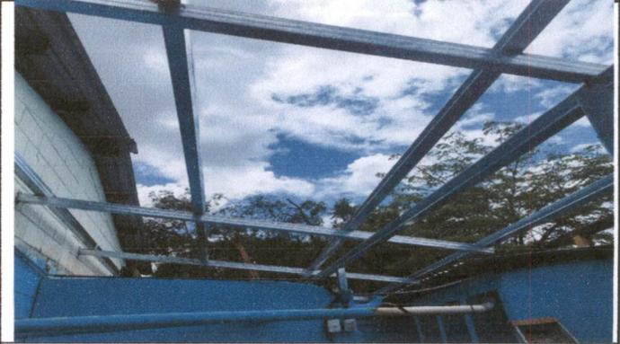
Foto 2: Colocación de lámina y costaneras.
