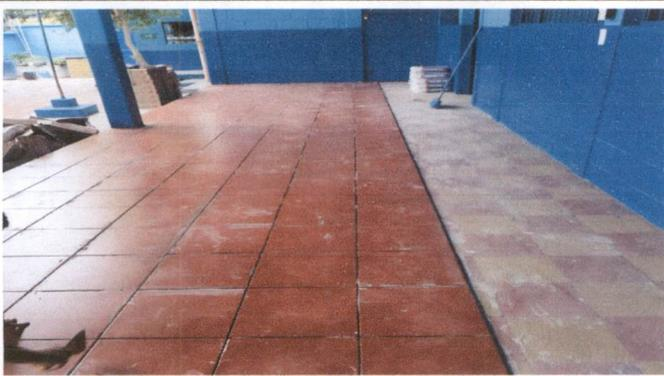
Foto 3: Colocación de piso cerámico en el corredor.
