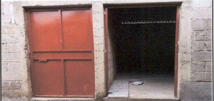
Foto 6: Mantenimiento a puertas metálicas
