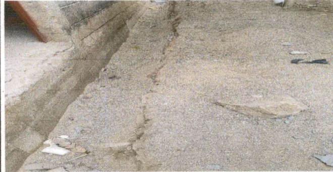
Foto 10: reparación de 7ML de Cuneta de Concreto
