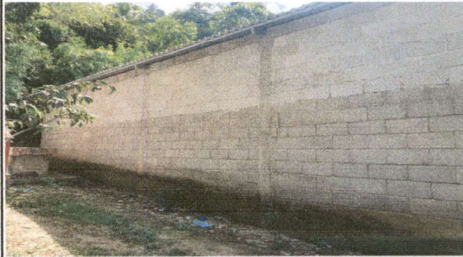
Foto 8: Reparación de repello columnas interiores y exteriores.
