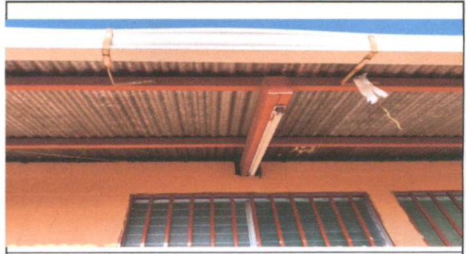
Foto No.8 Sistema Eléctrico
