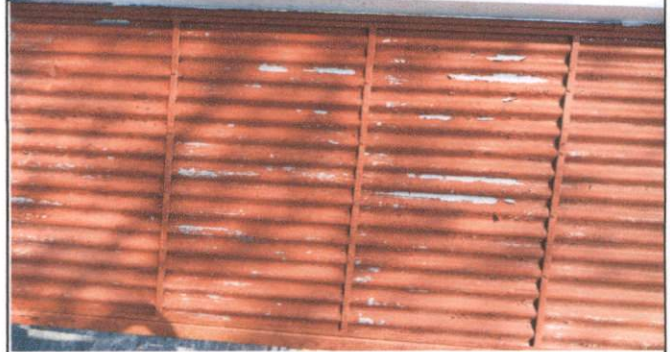
Foto No.2 Puertas de metal para sanitario
