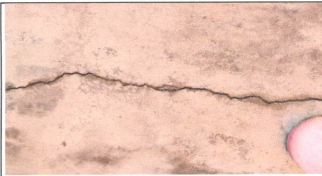
Foto No.3 Sustitución de piso
