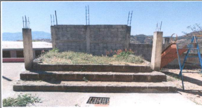
Foto No.1 Instalación de Techo y Canales
