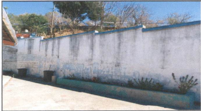
Foto No. 7 Reparación Muro Perimetral
