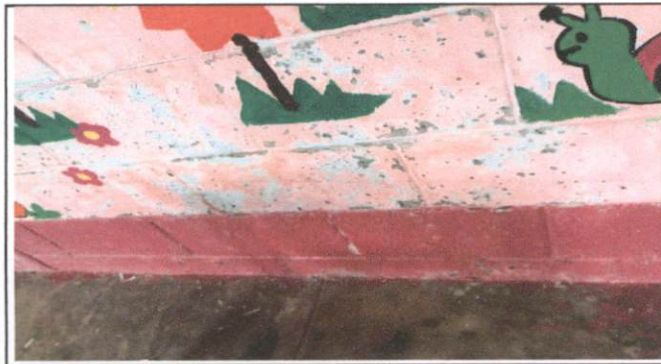
Foto No.9 Pintura de Interiores y exteriores
