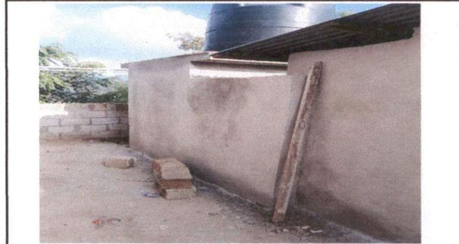
Foto 4: Repello en muros
