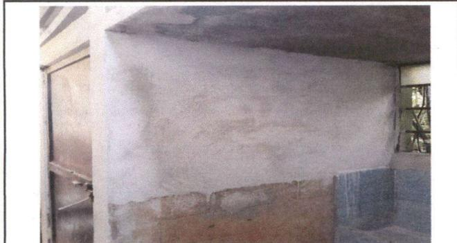
Foto 3: Repello en muros de sanitarios
