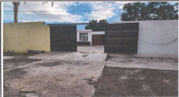
Foto 9: ELABORACIÓN E INASTALACIÓN DE ESTRUCTURA METÁLICA PARA TECHO TIPO SOMBRERO DE DOS AGUAS EN PORTÓN DE SALIDA DE LA ESCUELA
