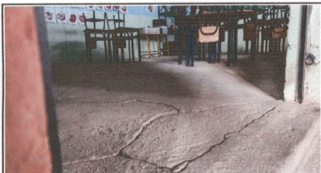
Foto 3: AULA 3 REPARACIÓN DE PISO DE TORTA DE CONCRETO E INSTALACIÓN DE PISO CERÁMICO
