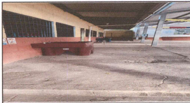
Foto 6: REPARACIÓN DE PLANCHAS DE CONCRETO EN ÁREA DE PATIO CON FUNDICIÓN DE CONCRETO CON ESPESOR DE 6CM
