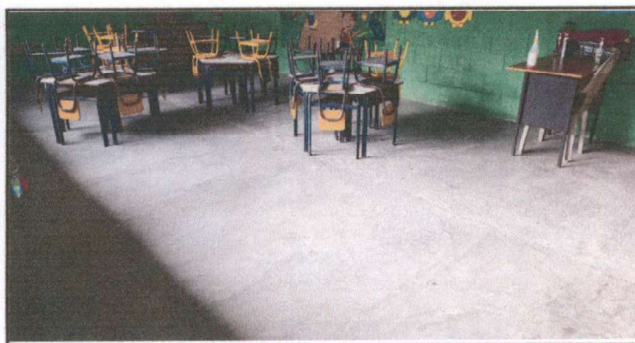
Foto 5: AULA 5 REPARACIÓN DE PISO DE TORTA DE CONCRETO E INSTALACIÓN DE PISO CERÁMICO
