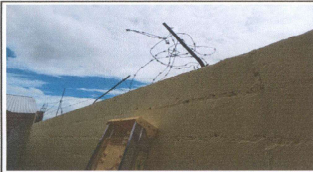
FOTO 7: REPARACIÓN E INSTALACIÓN DE MURO PERIMETRAL DE 2 HILADAS DE BLOCK
