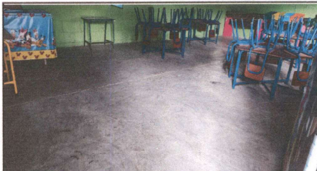
Foto 4: AULA 4 REPARACIÓN DE PISO DE TORTA DE CONCRETO E INSTALACIÓN DE PISO CERÁMICO
