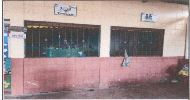
FOTO 10: AULA 1 MANTENIMIENTO Y REFUERZO EN BALCONES DE METAL DE LAS AULAS DEL ESTABLECIMIENTO EDUCATIVO.
