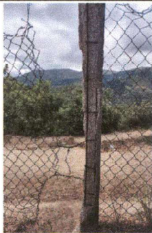
Foto 5: Reparación de los postes el muro perimetral.
