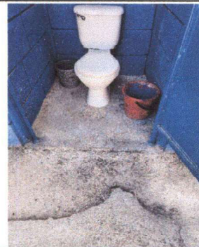
Foto 4: Reparación del piso de los baños.
