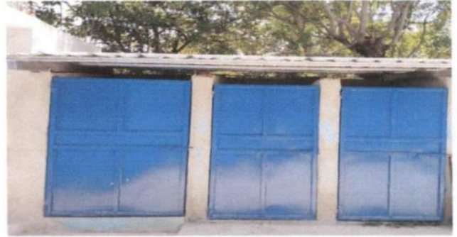
5.1 SUSTITUCIÓN DE PUERTAS
