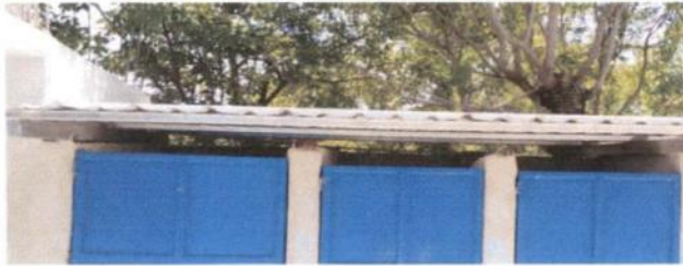
6.1 SUSTITUCIÓN DE LÁMINA, POR LAMINA TROQUELADA
