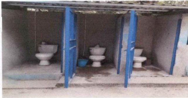
4.1 SUSTITUCIÓN E INSTALACIÓN DE INODOROS Y SUS ACCESORIOS
