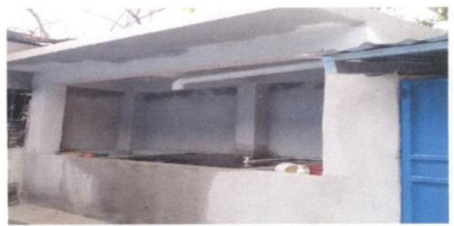
2.1 SUSTITUCIÓN DE PILA DE CEMENTO DE DOS LAVADEROS
