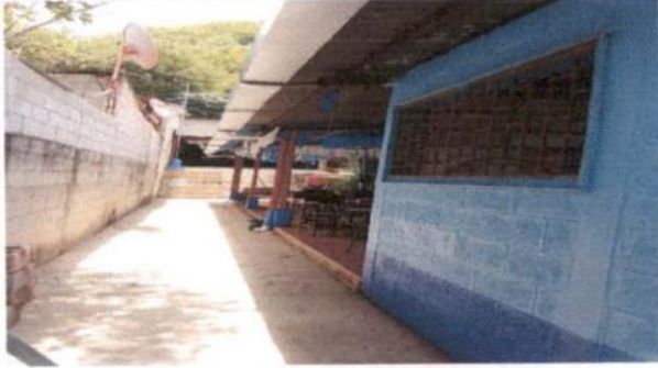
8.1 SUSTITUCIÓN DE BAJADA DE AGUA PLUVIAL POR TUBO PVC 3
