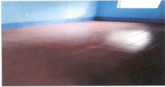
1.1 SUSTITUCIÓN E INSTALACION DE PISO
