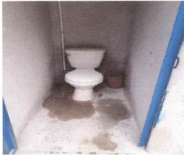
4.1 SUSTITUCIÓN E INSTALACIÓN DE INODOROS Y SUS ACCESORIOS
