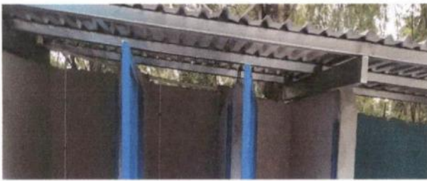
6.1 SUSTITUCIÓN DE LÁMINA, POR LAMINA TROQUELADA
