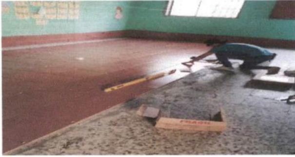
1.1 SUSTITUCIÓN E INSTALACION DE PISO
