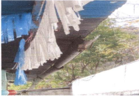
8.1 Sustitución de bajada de agua pluvial por tubo PVC 3
