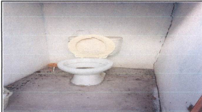
4.1 Sustitución e instalación de inodoros y sus accesorios
