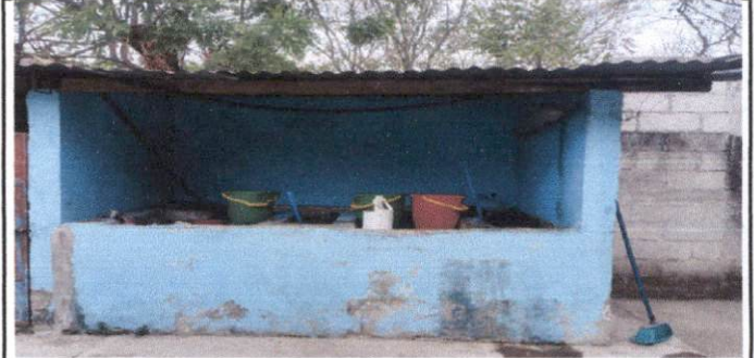
2.1 Sustitución de pila de cemento de dos lavaderos
