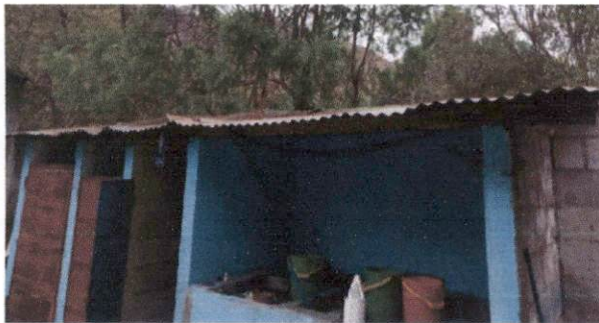
6.1 Sustitución de lámina , por lámina troquelada
