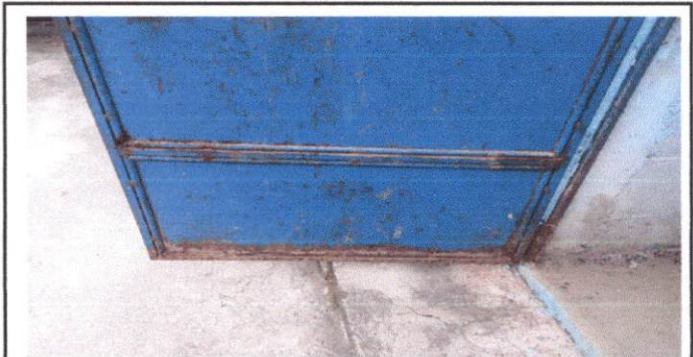
5.1 Sustitución de puertas de servicios sanitarios
