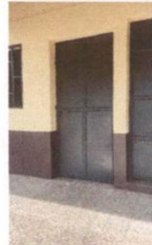
2. PUERTAS DE METAL 2.1 MANTENIMIENTO A ESTRUCTURA (LIJADO, CEPILLADO Y APLICACION DE PINTURA)
