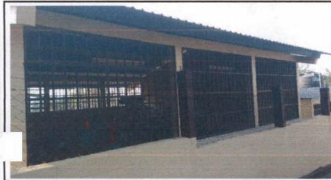
5. VENTANAS 5.1 ELABORACION E INSTALACION DE BALCONES DE METAL
