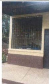
4. MANTENIMIENTO DE BARRANDAS
