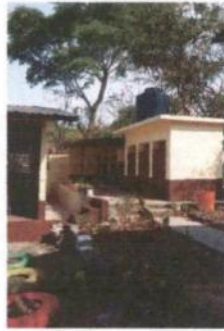
1. PINTURA EN MUROS EXTERIORES E INTERIORES
