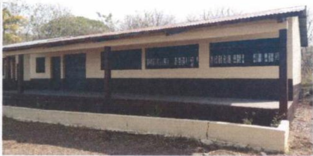
1. PINTURA EN MUROS EXTERIORES E INTERIORES
