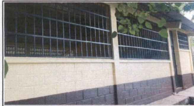
6. VENTANAS 5.1 ELABORACION E INSTALACION DE BALCONES DE METAL
