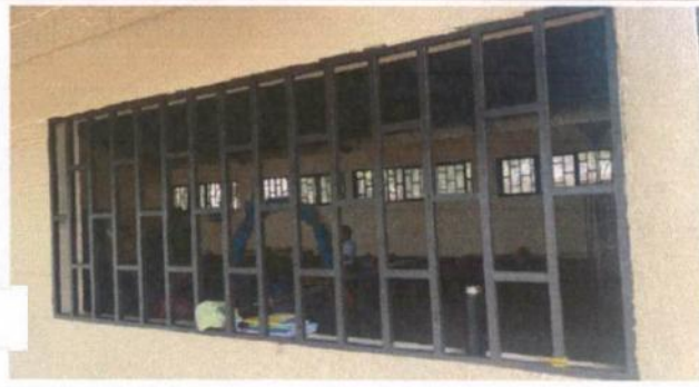
4. MANTENIMIENTO DE BARRANDAS
