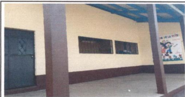
1. PINTURA EN MUROS EXTERIORES E INTERIORES
