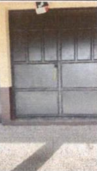
2. PUERTAS DE METAL 2.1 MANTENIMIENTO A ESTRUCTURA (LIJADO, CEPILLADO Y APLICACION DE PINTURA)
