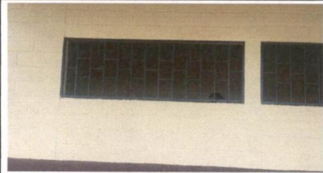
4. MANTENIMIENTO DE BARRANDAS
