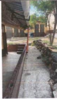
6. CANALES Y BAJADA DE AGUA PLUVIAL 6.1 REPARACION DE BAJADA DE AGUA PLUVIAL
