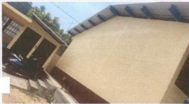
1. PINTURA EN MUROS EXTERIORES E INTERIORES
