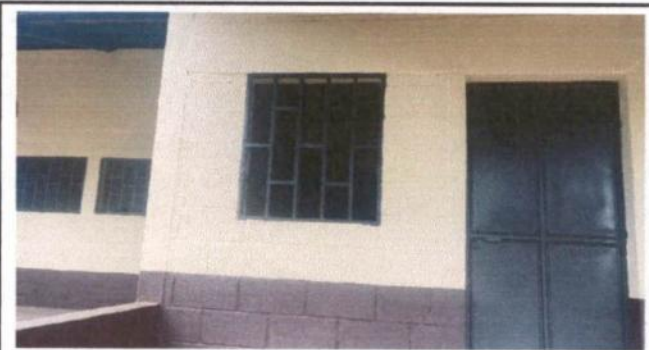
4. MANTENIMIENTO DE BARRANDAS
