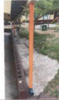
6. CANALES Y BAJADA DE AGUA PLUVIAL 6.1 REPARACION DE BAJADA DE AGUA PLUVIAL
