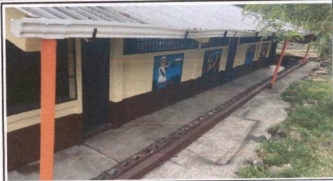
6. CANALES Y BAJADA DE AGUA PLUVIAL 6.1 REPARACION DE BAJADA DE AGUA PLUVIAL
