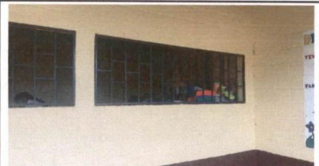
4. MANTENIMIENTO DE BARRANDAS
