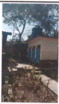
1. PINTURA EN MUROS EXTERIORES E INTERIORES
