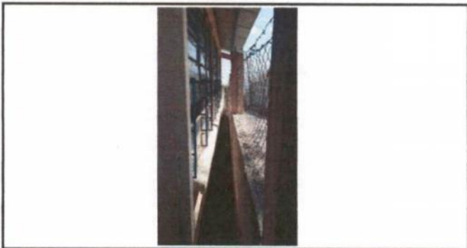
5. VENTANAS 5.1 ELABORACION E INSTALACION DE METAL
