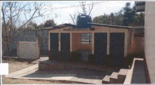
2. PUERTAS DE METAL 2.1 MANTENIMIENTO A ESTRUCTURA (LIJADO, CEPILLADO Y APLICACION DE PINTURA)
