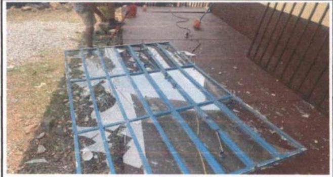
5. VENTANAS 5.1 ELABORACION E INSTALACION DE METAL
