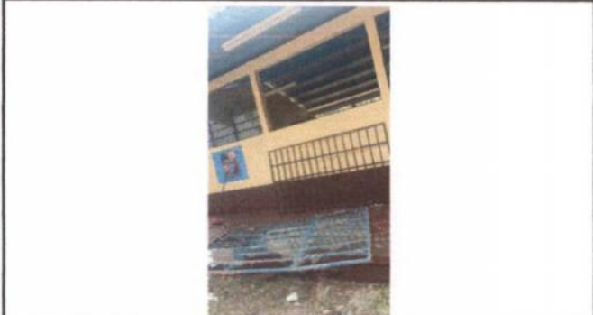
5. VENTANAS 5.1 ELABORACION E INSTALACION DE METAL
