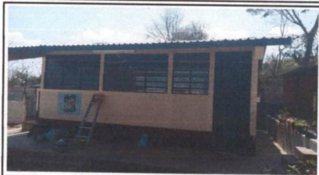
1. PINTURA EN MUROS EXTERIORES E INTERIORES
