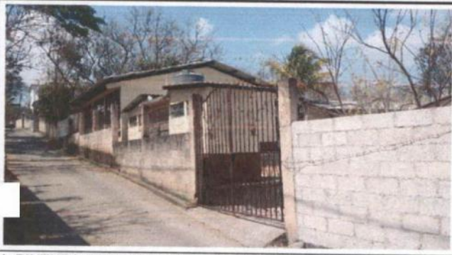
1. PINTURA EN MUROS EXTERIORES E INTERIORES
