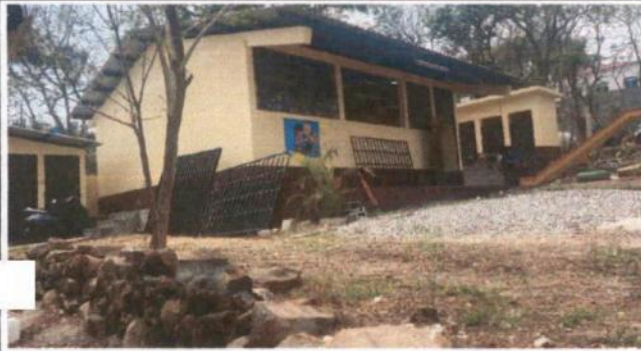
5. VENTANAS 5.1 ELABORACION E INSTALACION DE METAL
