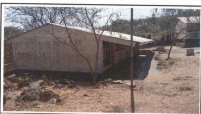
1. PINTURA EN MUROS EXTERIORES E INTERIORES
