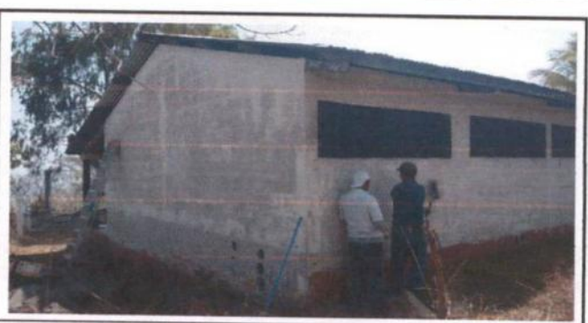
1. PINTURA EN MUROS EXTERIORES E INTERIORES
