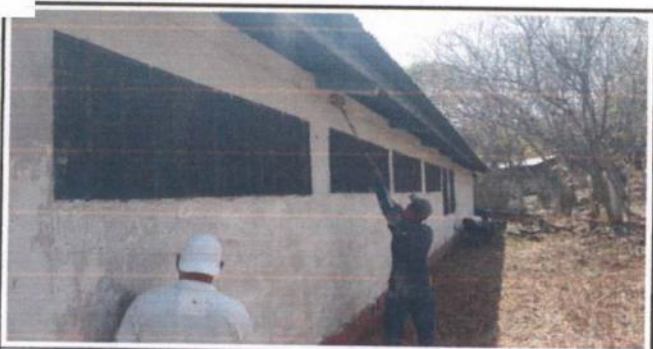
1. PINTURA EN MUROS EXTERIORES E INTERIORES
