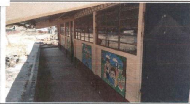
5. VENTANAS 5.1 ELABORACION E INSTALACION DE METAL
