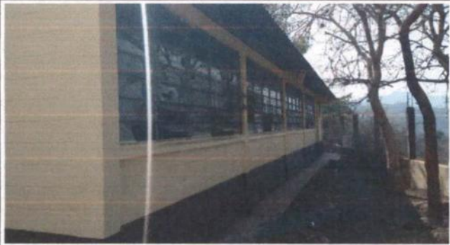
5. VENTANAS 5.1 ELABORACION E INSTALACION DE METAL
