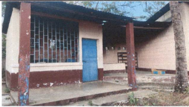
FOTO 7: MANTENIMIENTO DE BARANDAS
