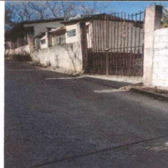
Foto 6: MANTENIMIENTO A PORTÓN
