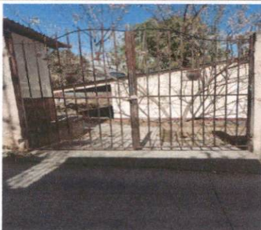
Foto 5: MANTENIMIENTO A PORTÓN
