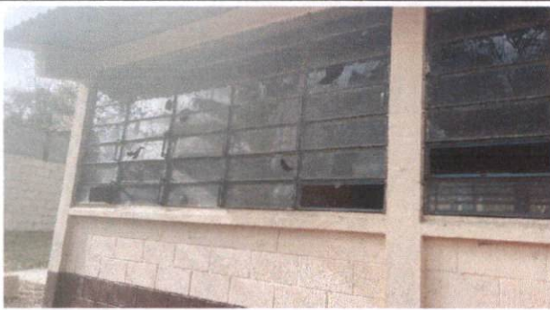
Foto 9: VENTANAS. ELABORACIÓN E INSTALACIÓN DE BALCONES DE METAL
