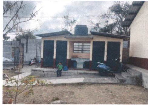
Foto 4: PUERTAS DE METAL. MANTENIMIENTO A ESTRUCTURA ( LIJADO, CEPILLADO Y APLICACIÓN DE PINTURA)
