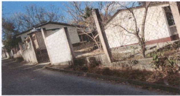
FOTO 1: PINTURA EN MUROS EXTERIORES E INTERIORES
