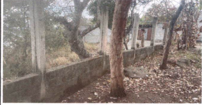
FOTO 2: PINTURA EN MUROS EXTERIORES E INTERIORES
