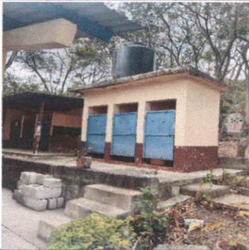
Foto 3: PUERTAS DE METAL. MANTENIMIENTO A ESTRUCTURA ( LIJADO, CEPILLADO Y APLICACIÓN DE PINTURA)
