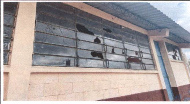
Foto 10: VENTANAS. ELABORACIÓN E INSTALACIÓN DE BALCONES DE METAL
