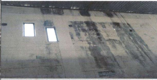
ENTRADA DE AGUA LLUVIAL POR LAS GRADAS AL SEGUNDO NIVEL
