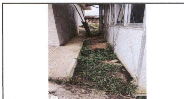
Foto 6: CUNETETA DE CONCRETO: REPARACIÓN DE CUNETETA DE CONCRETO (6 METROS CUADRADOS).
