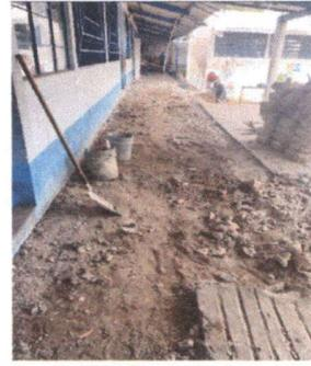
Foto 2: Fundición de contrapiso de 5 cms en área de pasillos del instituto y ampliación de escenario existente
