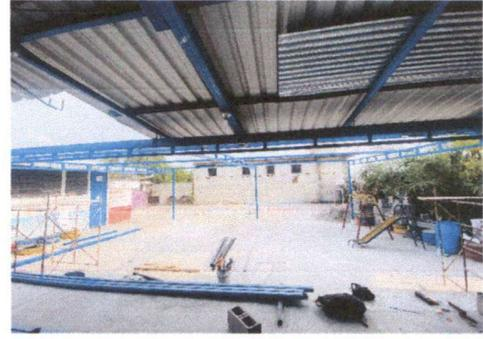
Foto2: ESTRUCTURA DE TECHO: Estructura metálica con tubería de 3\*3 y de 2\*2 con Joist y carga, lámina de costanera de 3\*2 más enlaminado con lámina troquelada calibre 26
