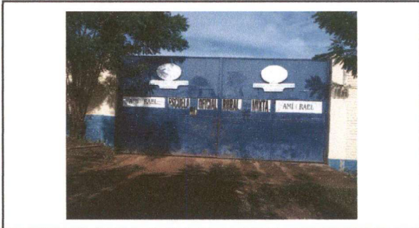
Foto 2: REPARACIÓN DE PORTON PRINCIPAL
