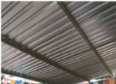
Foto 5: REPARACIÓN DE GALERA
