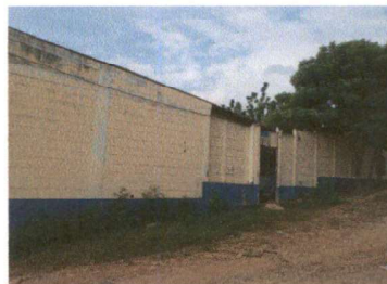
Foto 6: PINTURA DE EXTERIORES
