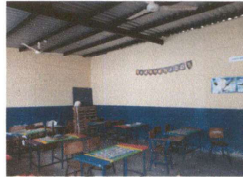
Foto 2: PINTURA EN MUROS DE EXTERIORES E INTERIORES
