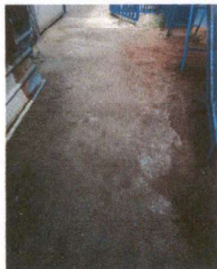
Foto 1: REPARACIÓN DE PISO DE LOSA
