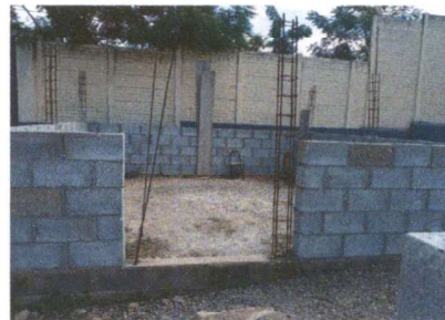
Foto 4: REPARACIÓN DE MURO EN EL ÁREA DE DIRECCIÓN
