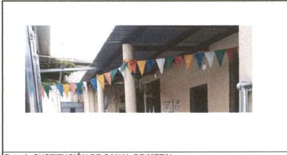
Foto 6: SUSTITUCIÓN DE CANAL DE METAL
