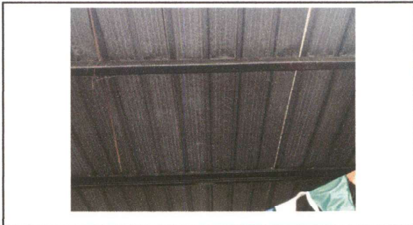
Foto 4: SUSTITUCIÓN DE LÁMINA POR LÁMINA TROQUELADA
