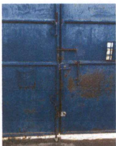
Foto 3: REPARACIÓN DE PORTON PRINCIPAL
