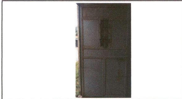
Foto 1: REPARACIÓN DE PUERTA DE INGRESO
