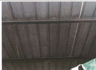
Foto 4: SUSTITUCIÓN DE LÁMINA POR LÁMINA TROQUELADA
