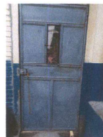
Foto 6: REPARACIÓN DE PUERTA DE INGRESO
