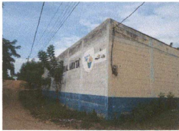
Foto1: PINTURA EN MUROS DE EXTERIORES E INTERIORES
