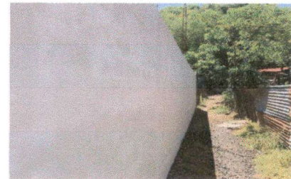
Foto 6: Muro perimetral del establecimiento con cernido
