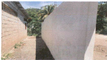
Foto 5: Reparación de muro perimetral existente
