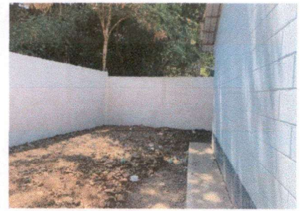
Foto 2: Muro perimetral con repello y cernido
