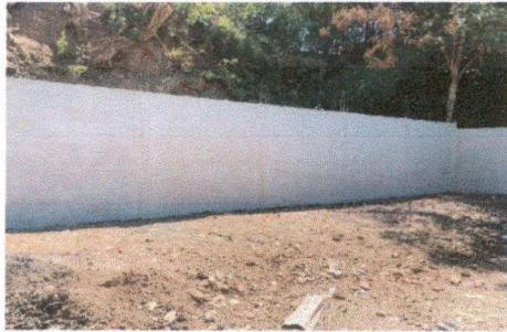
Foto1: .Muro perimetral con repello y cernido
