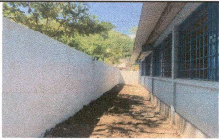
Foto 3: Muro perimetral con repello y cernido
