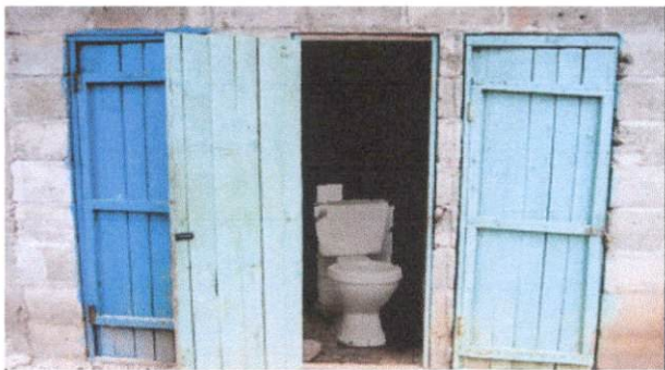
Foto 4: sustitucion de inodoros.
