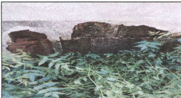
Foto 5 : reparación de muro perimetral.
