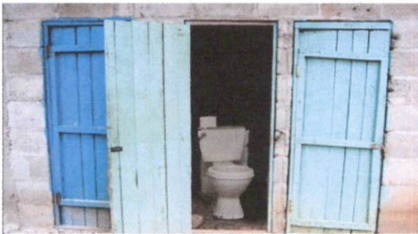
Foto 3: sustituir puertas de madera, por puertas de metal.
