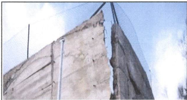
Foto 6: reparación de muro de contención.
