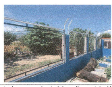
Foto 4: Mantenimiento de muro perimetral de malla con tubo HG
