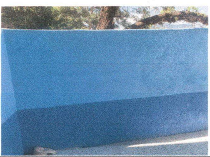
Foto1: .Pintura en muros interior y exterior
