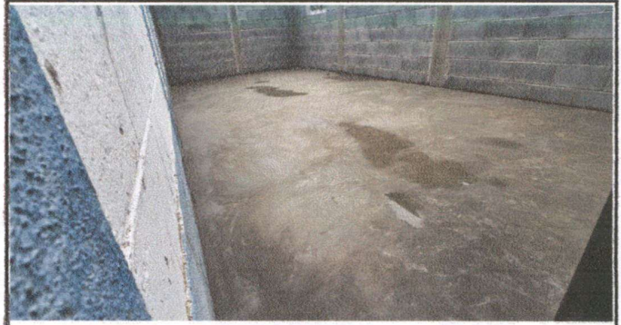
Foto 2: Reparación del entortado de cemento del aula
