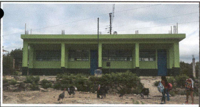
Foto 5: Fachada frontal pintada y mejorada.
