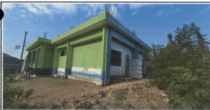
Foto 5: Aplicación de pintura en salones posteriores.
