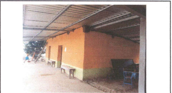
CUBIERTA DE LAMINA
