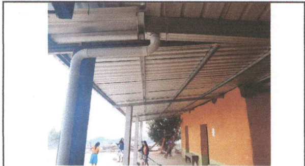
SUSTITUCIÓN DE LAMINA POR LAMINA TROQUELADA
